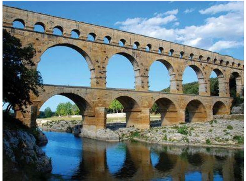
Pont du Gard, France. Britannica.com .
